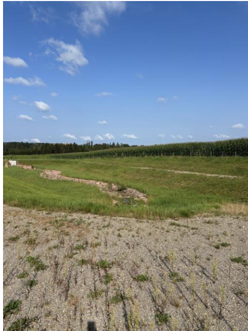
Regenrückhaltebecken im östlichen Teil der Planflä- che (Blick von Osten)
