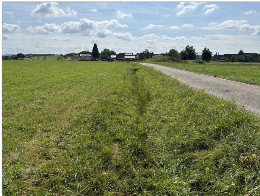
Entwässerungsgraben zum Weg hin (Blick von Nordwesten)
