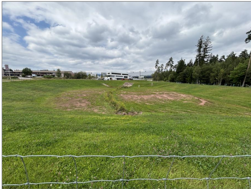
Regenrückhaltebecken (Blick von Süden)
