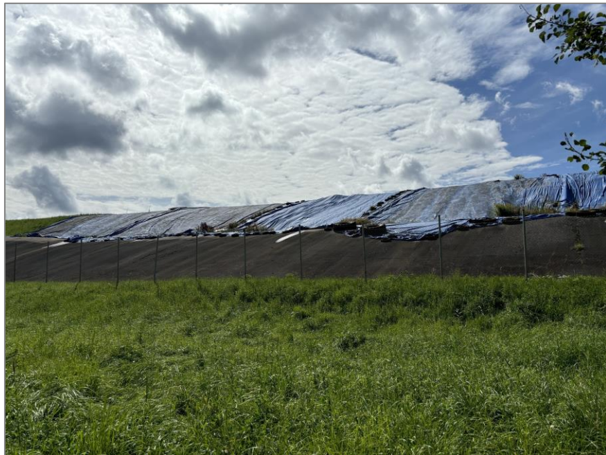
Deponie (Blick von Norden)
