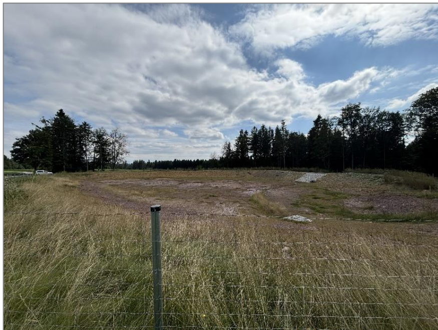
Regenrückhaltbecken (Blick von Norden)
