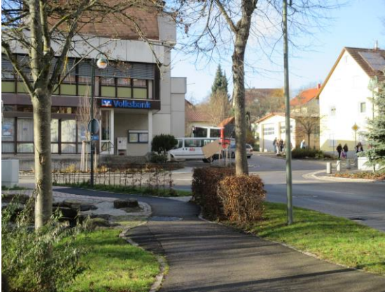
Abbildung 40: Versorgungszentrum am Johanniterplatz (Quelle: WHS 2016)
