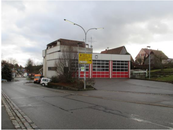
Abbildung 34: Mehrzweckgebäude mit Feuerwehrmagazin (Quelle: WHS 2016)
