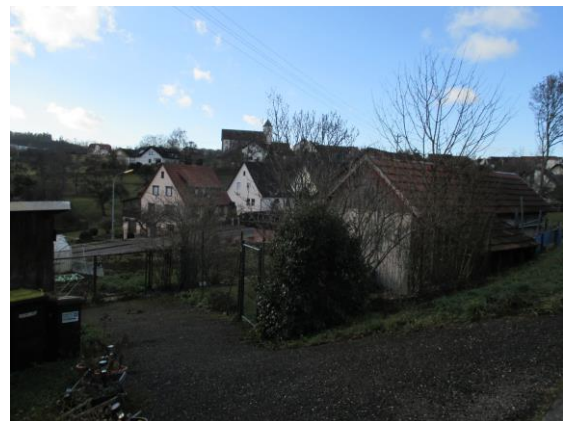
Abbildung 9: Rohrdorfer Straße Blick in Richtung Süden (Quelle: WHS 2016)
