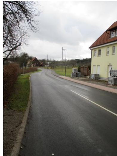
Abbildung 53: Ortseinfahrt Süd (Quelle: WHS 2016)
