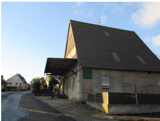
Abbildung 32: Beispielgebäude in der Badstraße (Quelle: WHS 2016)
