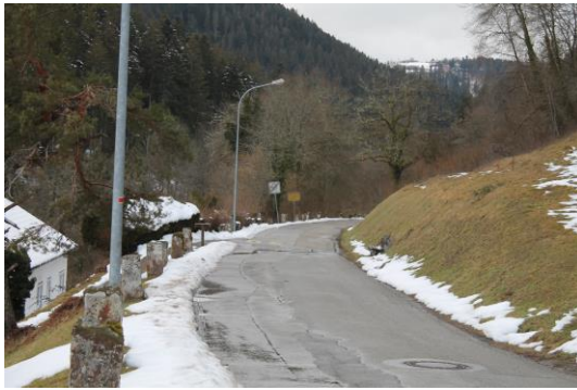
Abbildung 47: Ortseingang Seehalde (Quelle: WHS 2019)
