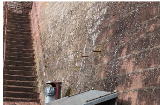
Abbildung 44: Treppenanlage Schloßsteige (Quelle: WHS 2019)
