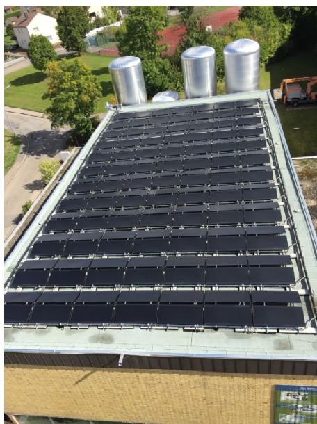
Abb. 28: Absorberanlage und Wärmepumpe Heizzentrale Hohenbergschule
