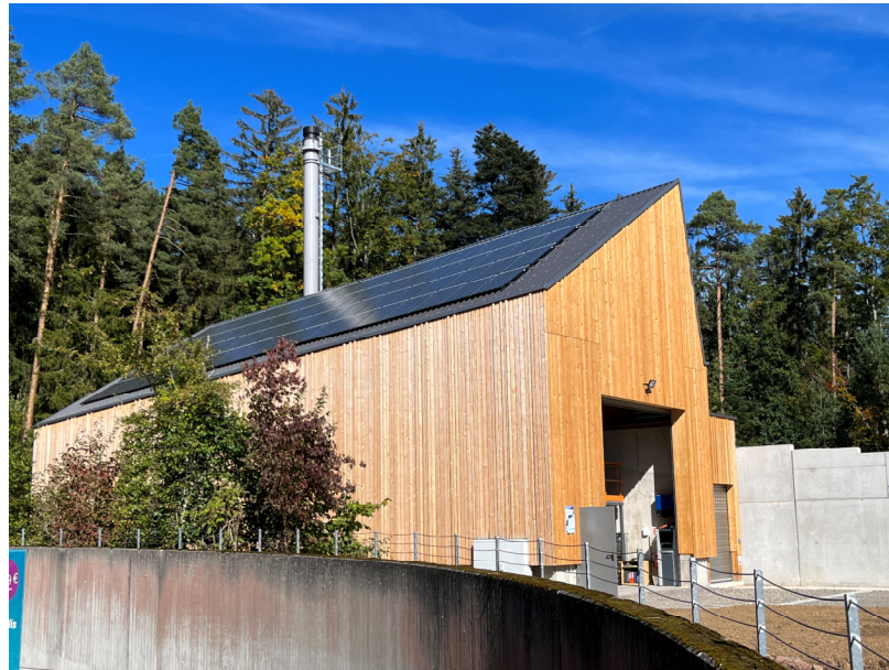
Abb. 115: Heizzentrale in Wart
