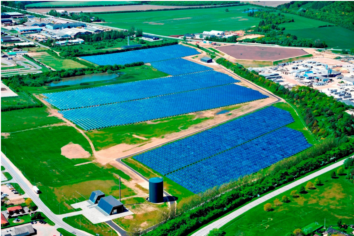
Abb. 62: Solarthermieranlage mit Erdbeckenwärmespeicher (Wärmespeicher oben rechts im Bild/ Quelle: www.vojensfjernvarme.dk )
