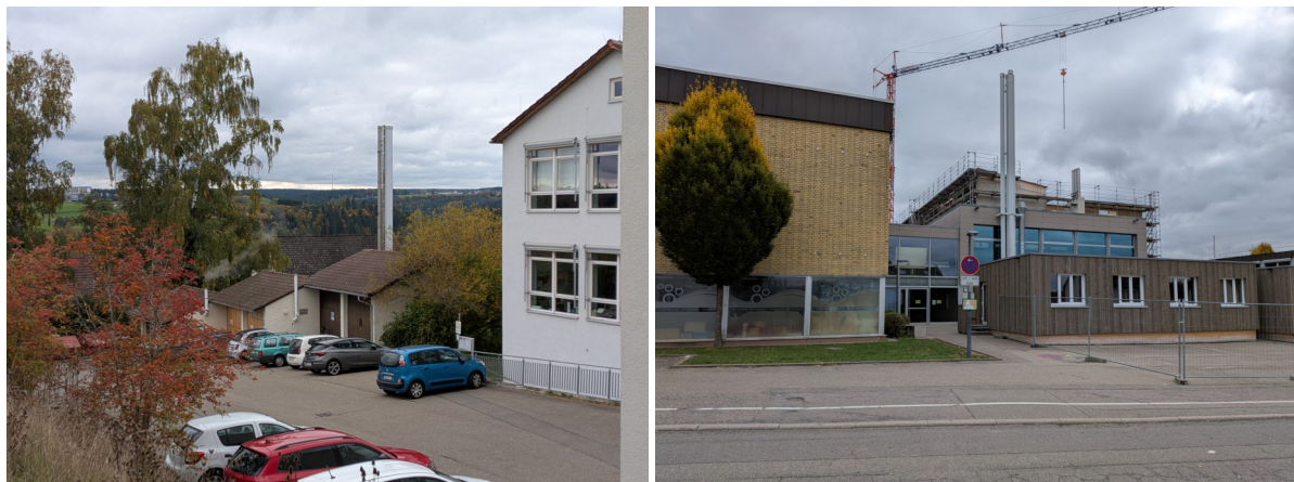
Abb. 114: Heizzentralen Christophorus-Gymnasium (links) und Hohenbergschule (rechts)
