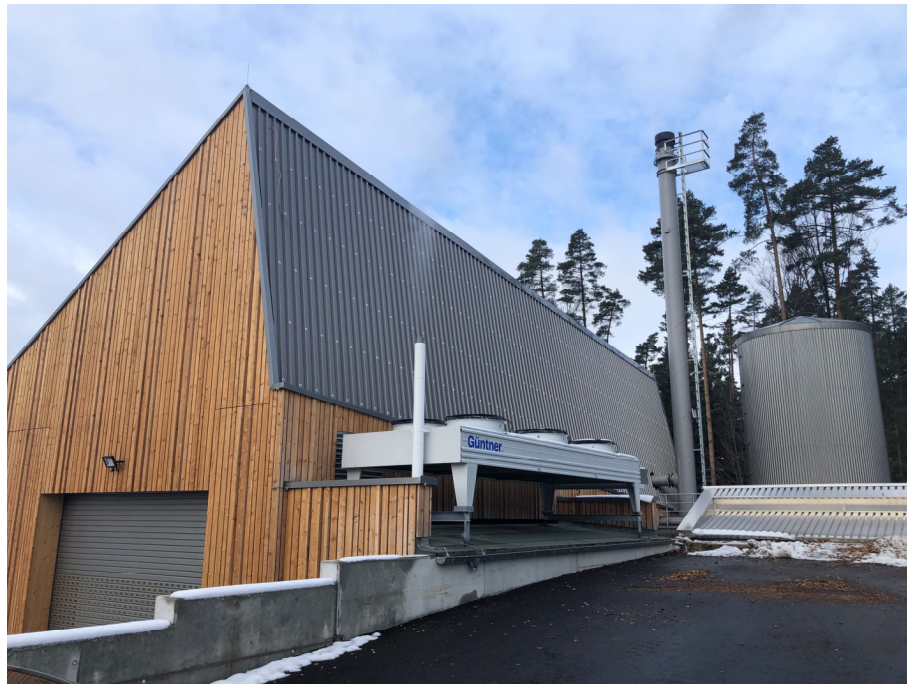
Abb. 32: Außenansicht Heizzentrale Wart
