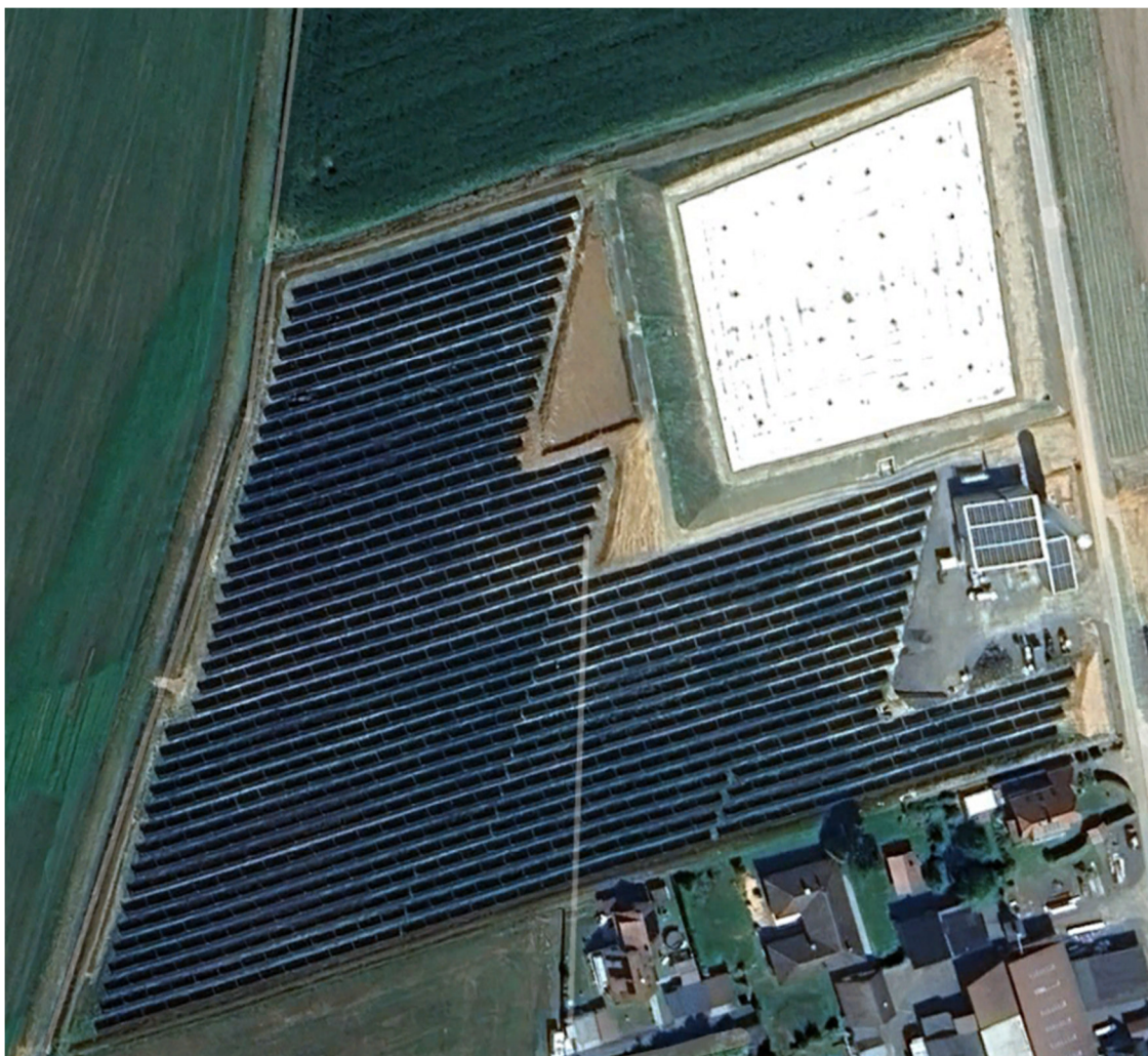
Abb. 63: Solarthermiefeld, Grubenspeicher und Heizzentrale in Bracht (Quellen: www.solarwaerme-bracht.de , Google Earth)
