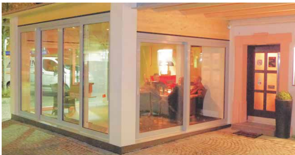
Die Schiebetüren des neuen Wintergartens lassen sich an allen drei Seiten zur Hälfte öffnen. Eine weitere Schiebetür trennt den bisherigen Restaurantbereich vom neuen Raucherbereich.
