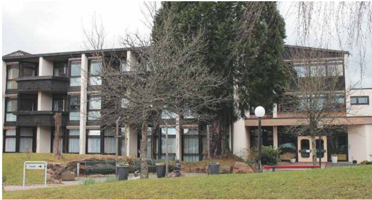
Das Gebäude des Seniorenheims wird umfangreich saniert und umgebaut.
