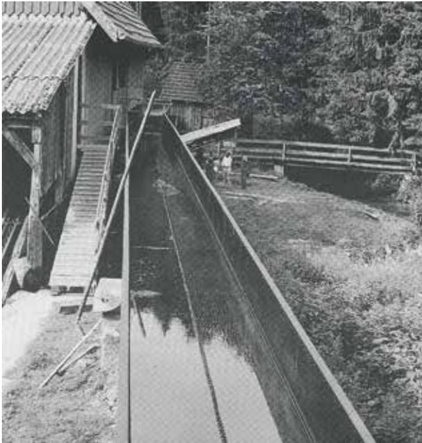
***Ein 33 m langer Kanal aus Stahlblech führt dem oberflächigen Wasserrad das Triebwasser zu.***
