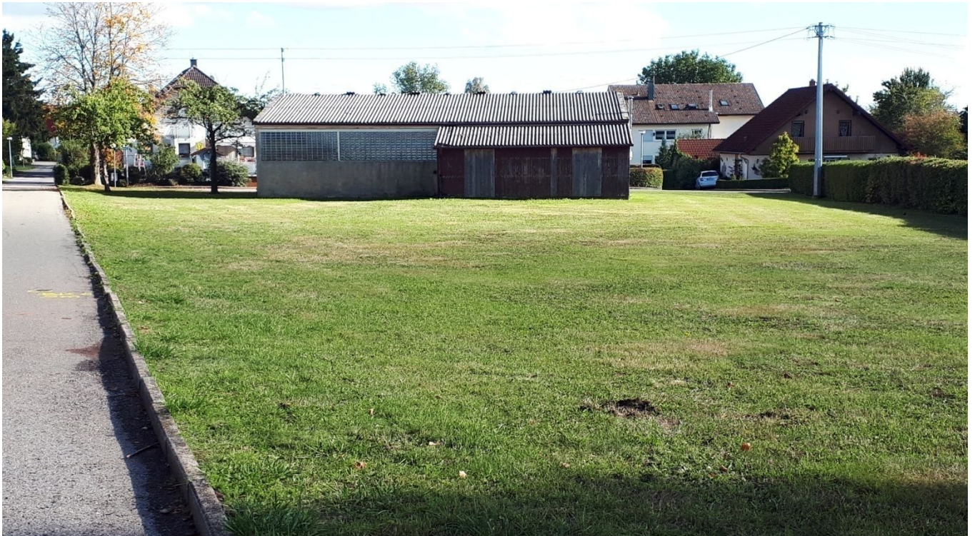
Blick von Nordwesten
