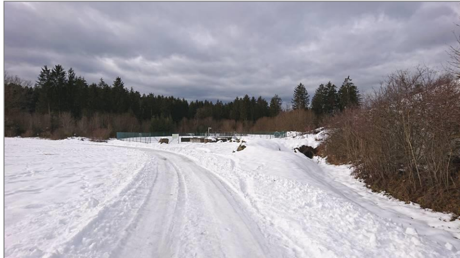
Regenwasserrückhaltebecken und Gräben rechts des Wegs nördlich der Planfläche
